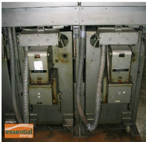
Westinghouse B18 type switchgear_.jpg
