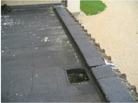
asbestos bitumen roof.jpg
