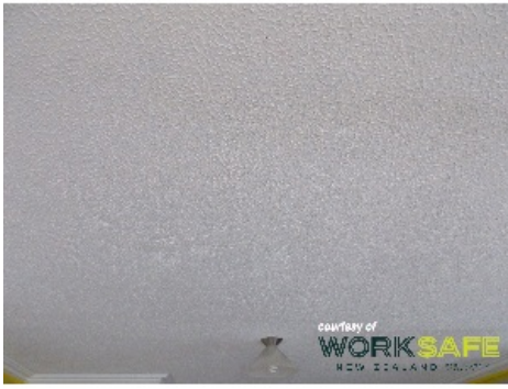
Plaster Ceiling DSCN7848.jpg
