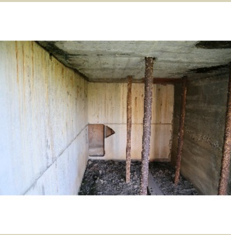
Under House WCS 025.JPG
