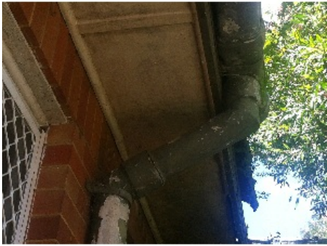
Asbestos Downpipe gutter eave _1998.JPG
