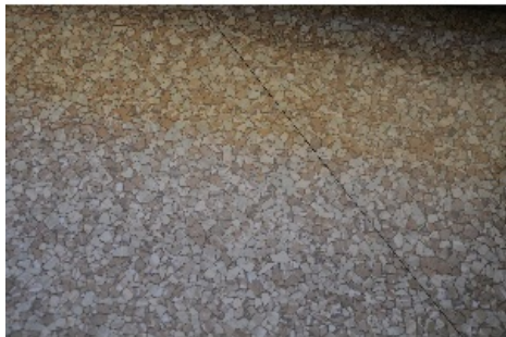
Asbestos Homes 101.JPG
