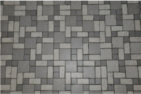
Asbestos Flooring - Tiles-2.jpg
