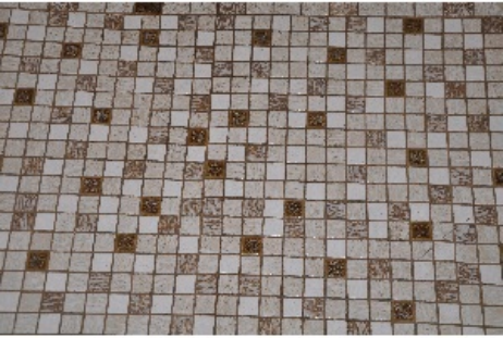
Asbestos Flooring - Tiles-5.jpg
