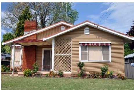
Asbestos Homes 095.JPG
