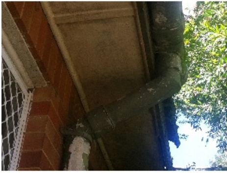
Asbestos Downpipe gutter eave_1998.JPG
